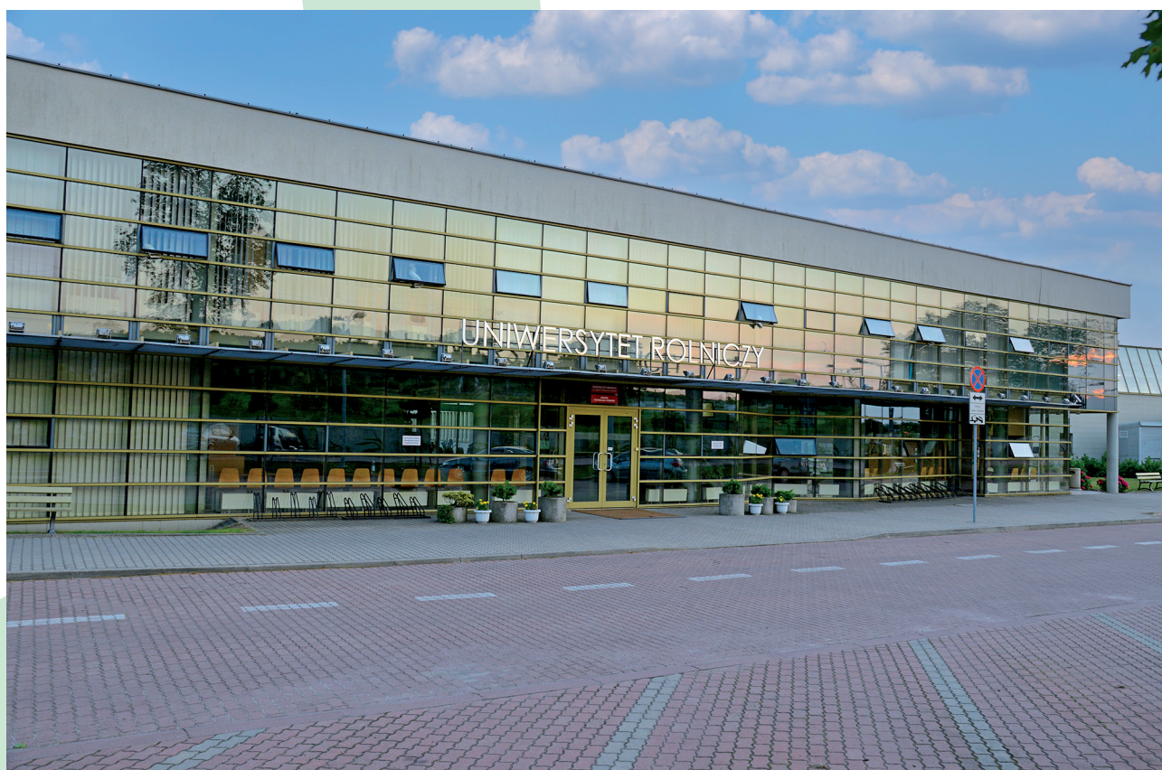
Budynek przy ul. Balickiej 122. Siedziba Wydziału Technologii Żywności. Fot. G. Wojcieszek
