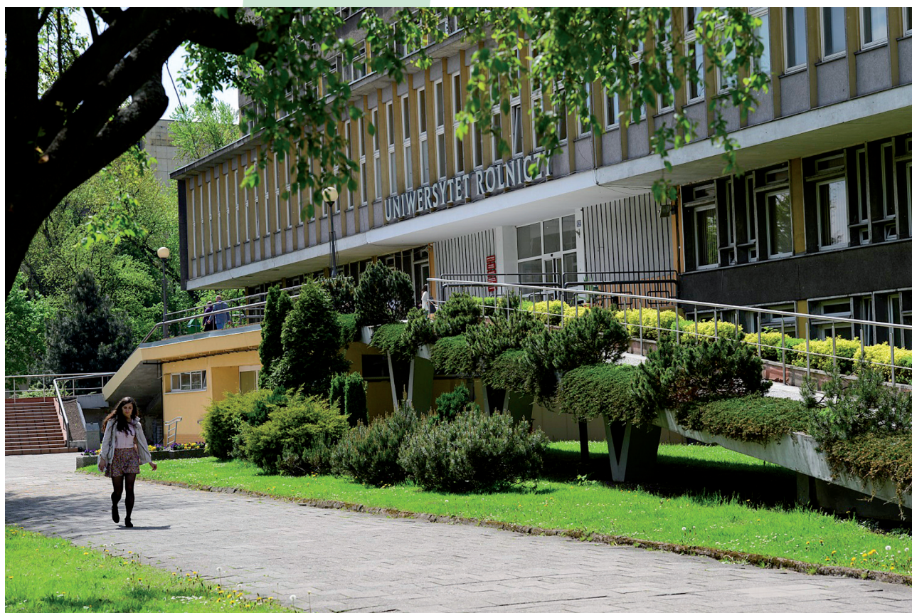
Budynek Jubileuszowy. Siedziba Wydziału Hodowli i Biologii Zwierząt oraz Wydziału Inżynierii Środowiska i Geodezji. Fot. z Archiwum URK
